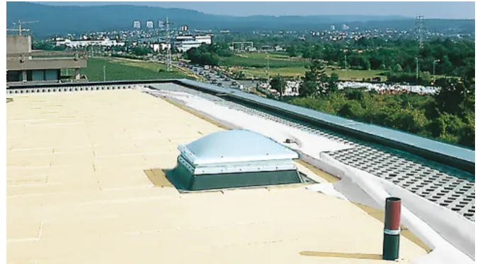
Gedämmtes Umkehrdach
