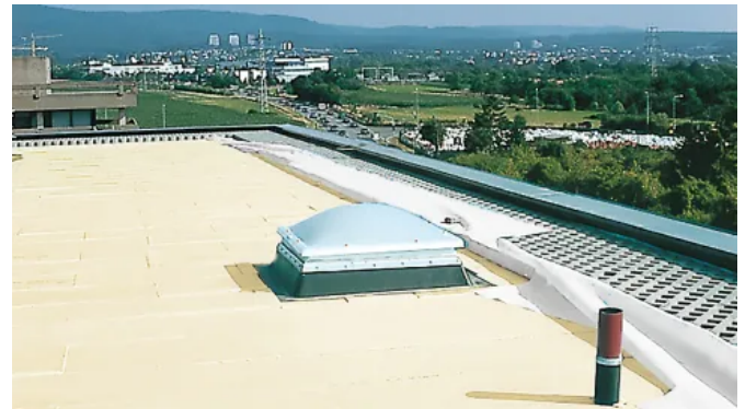
Gedämmtes Umkehrdach
