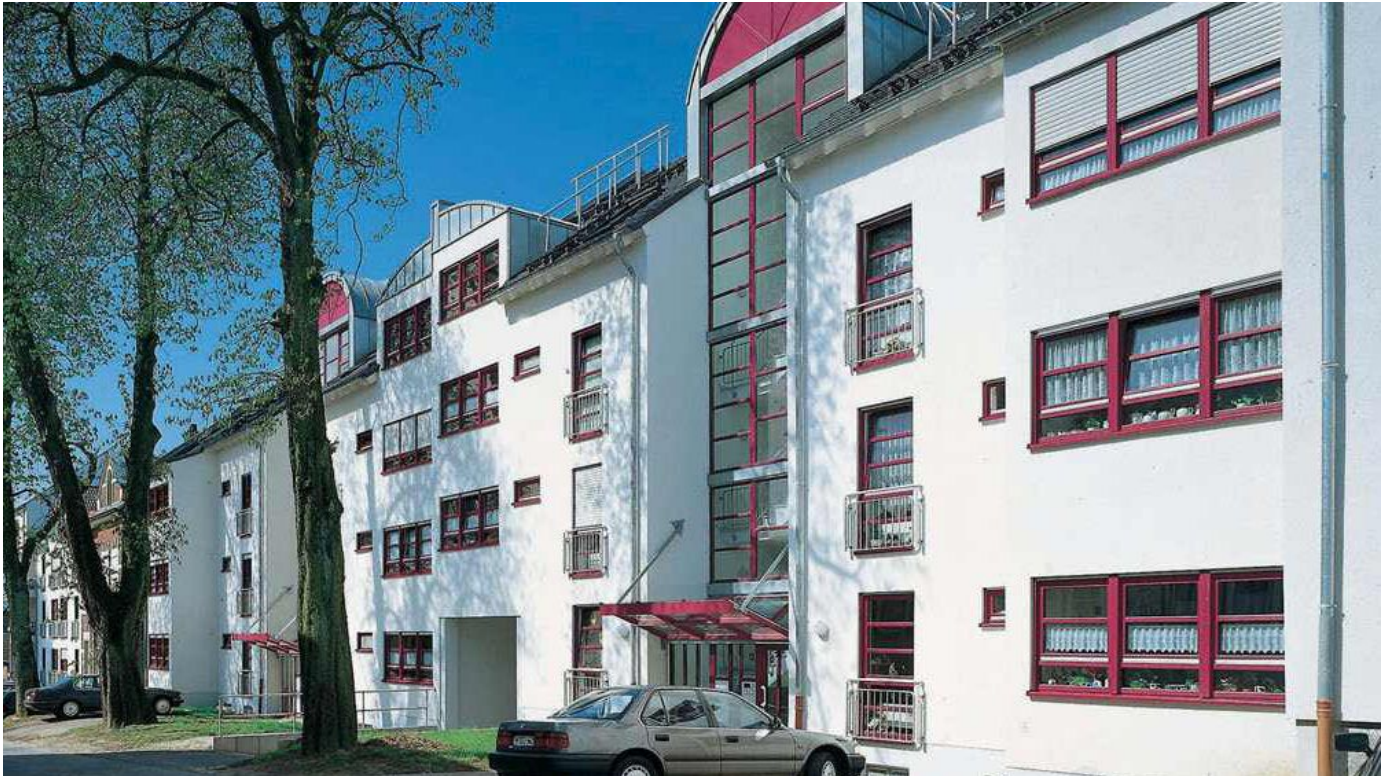
Wärmedämm-System mit mineralischem Dämmputz und mineralischen Edelputzen
