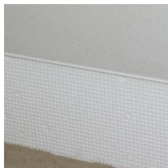
Schritt 6: Verklebung der Sockeldämmplatten inkl. WDVS Dichtband.
