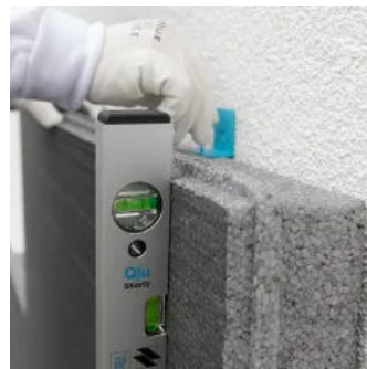
Schritt 3: Qju Dämmplatten ins Lot stellen und oberseitig mit Qju Fixierungswinkeln inkl. Nägeln fixieren.
