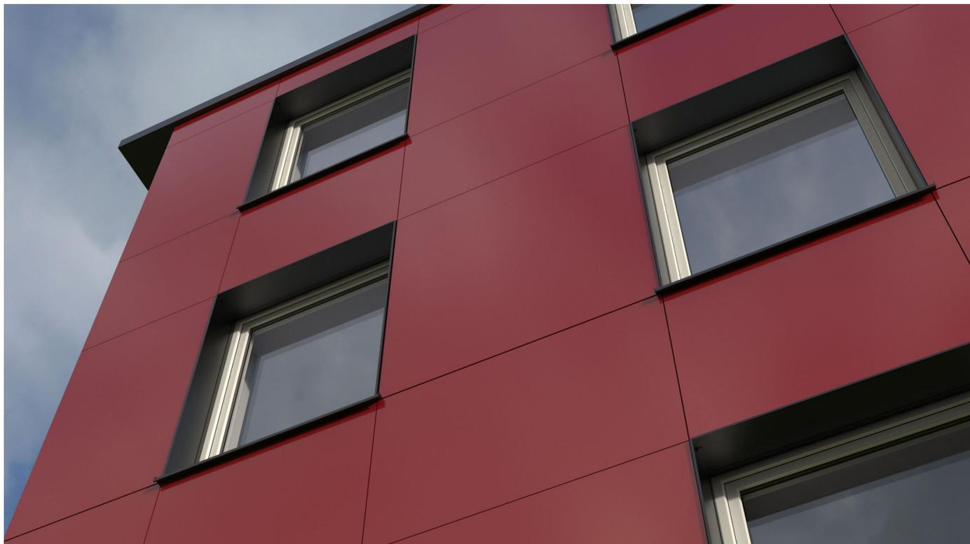
Das Fensterlaibungs- und Bekleidungsargensystem 'COVER' aus Aluminium vereint Design und Funktionalität auf nachhaltige Weise. Bei dem Herstellungsprozess wird auf umweltfreundliche Materialien und Produktionsverfahren gesetzt. Es ist für alle Fensterprofile geeignet und verfügt über fassadenoptimierte Profile, die eine effiziente Montage ermöglichen. Zusätzlich ist es kombinierbar mit Absturzsicherungssystemen und Rollladenführungsschienen.
