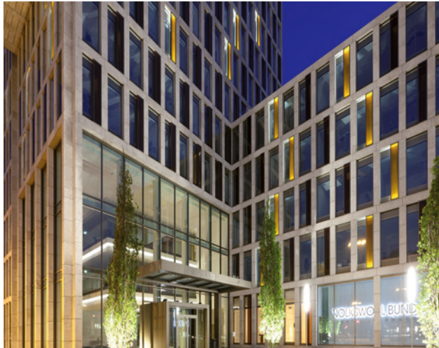
Fassade (linke Seite): COOL-LITE SKN 165, Fassade (rechte Seite): CLIMATOP PROTECT (3-fach ISO) + STADIP COLOR orange (Paneele)
