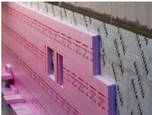
DELTA®-THENE verhindert das kapillare Eindringen von Wasser in das Bauteil.
