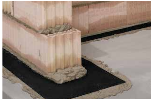
Mauerwerkssperre (MSB-Q) im Mörtelbett
