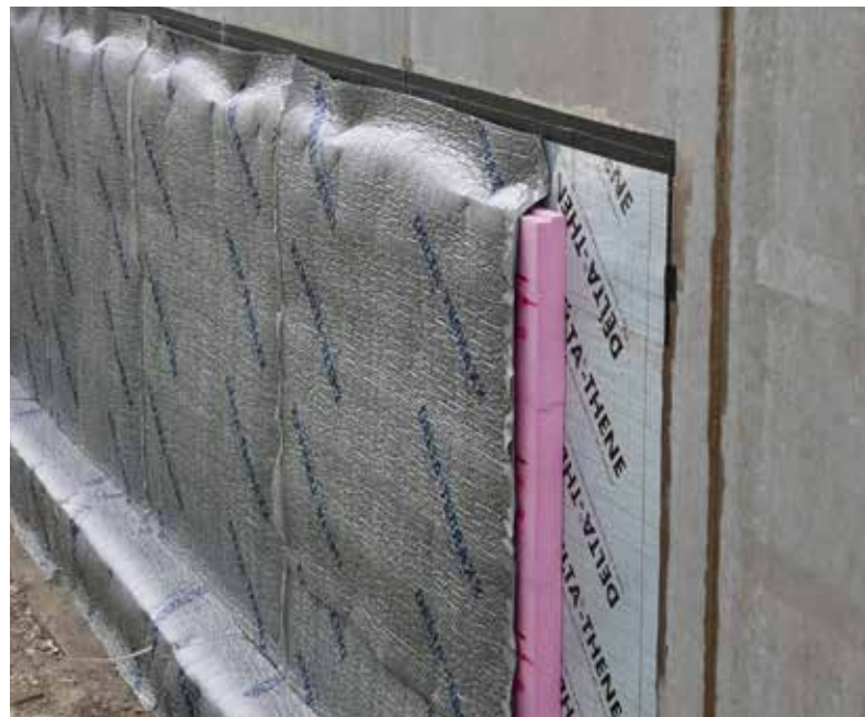
Temporäre Befestigung von DELTA®-TERRAXX mittels DELTA®-TERRAXX-SCHRAUBE an der Stirnseite der Dämmung.
