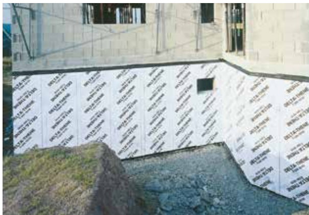
DELTA®-THENE ist eine hervorragende Dampfsperre.
