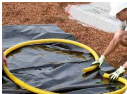
Mit Dränschläuchen und Folien entstehen temporäre Wasserflächen.
