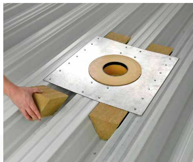
Abb. 6/1: Kleine Durchdringung: Sickenfüller in den Tiefsicken des Trapezblechs verhindern die Brandweiterleitung
