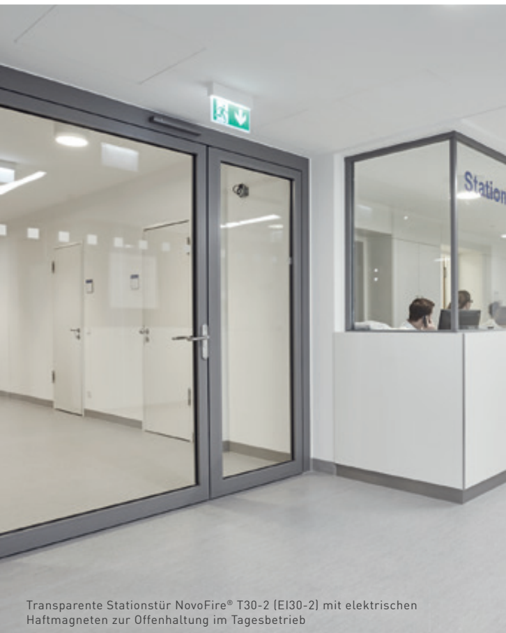
Brandschutztür NovoFire® mit einem Paneel im Durchgangsbereich
