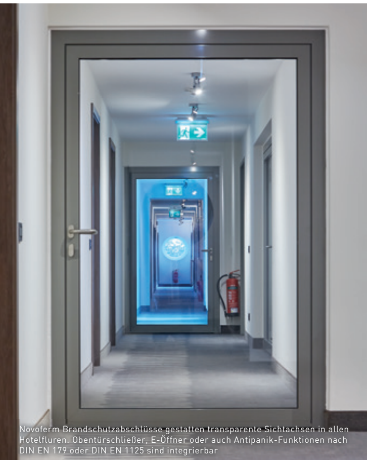
Ganzglaswände in der Ausführung T30 (EI, 30) lauch mit integrierter Tür von Novoferm für transparente Raumabschlüsse für offene Raumgestaltung
