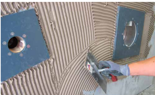
5 Aufzahn an der Betonwand mit Sopro's No.1 S1 Flexkleber als Haftbrücke für den folgenden Sopro SchwimmBadPutz.
