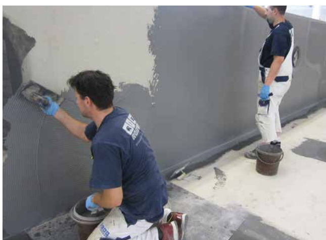
Die Verbundabdichtung (Sopro TurboDichtSchlämme 2-K) lässt sich durch Spachteln oder Spritzen sicher applizieren.
