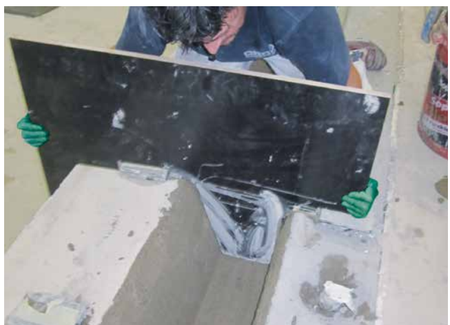
Mit Schablonen lässt sich der Beckenkopf sehr genau modellieren.
