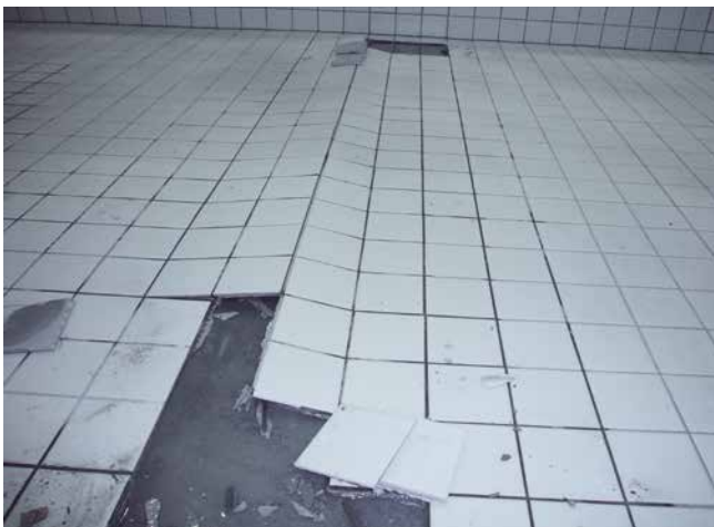
Dachförmiges Aufstellen eines Fliesenbelages auf einem Beckenboden.
