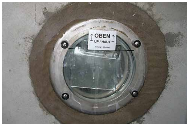
Scheinwerfergehäuse mit kapillarbrechender Spachtelung, hergestellt mit Sopro DünnettEpoxi.
