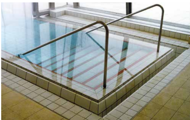
Finnische Rinne im Bereich einer Treppe.
