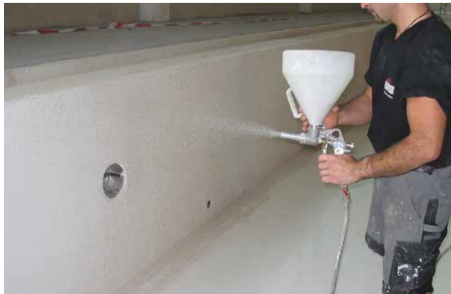
10 Abstreuen der mit Sopro PU-FlächenDicht Wand abgedichteten Fläche mit Quarzsand mittels Trichterpistole.
