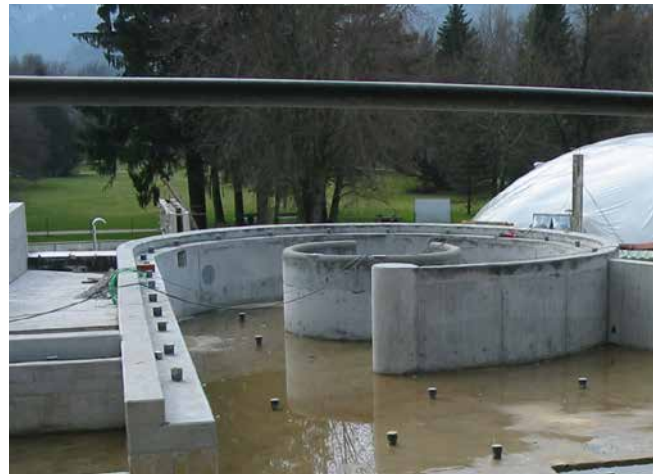
Im Betonbecken sollte kein Wasser stehen, da die Trocknung dadurch negativ beeinflusst wird.
