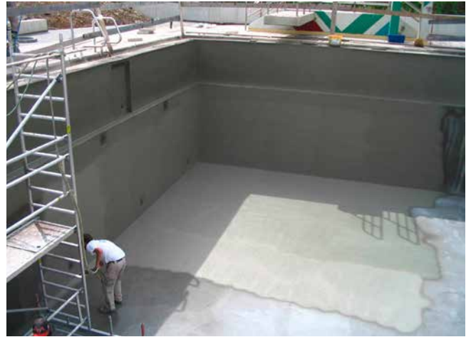
Abdichten eines Springerbeckens im Spritzverfahren.
