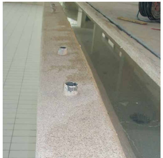
Hülsen im Beckenkopf für spätere Geländeranbindung.
