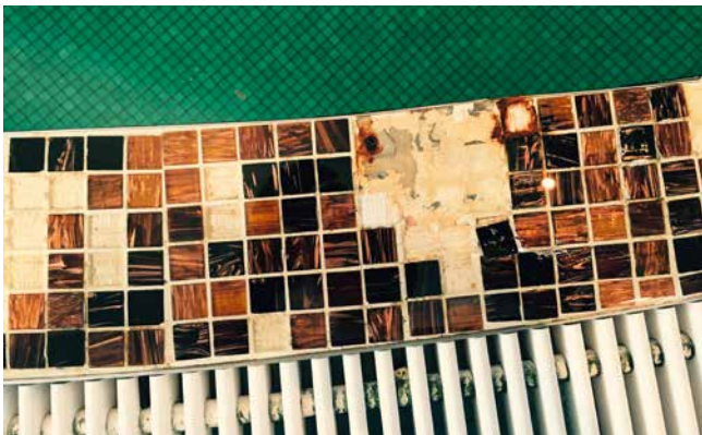
Abgelöste Glasmosaiksteine am Beckenkopf.
