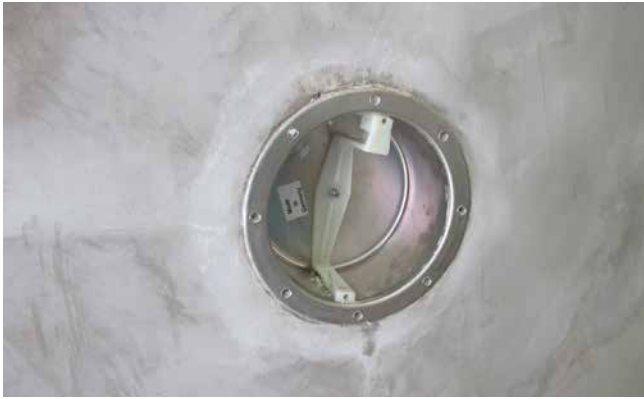
1 Einbetonierter Scheinwerfer.
