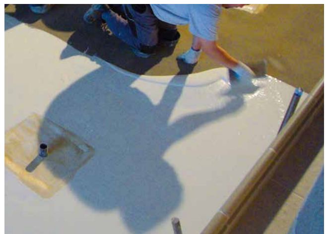
6 Abdichten eines Beckens mit Sopro PU-FlächenDicht.
