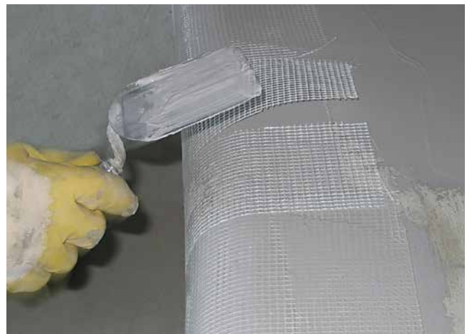
4 Einarbeiten von Armierungsgewebe in die Verbundabdichtung im Unterwasserbereich.
