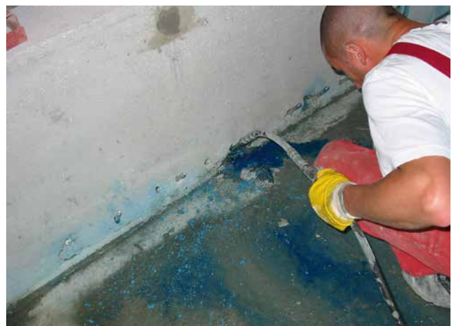
Rissverpressung an einem WU-Betonbecken.
