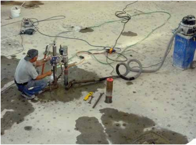
Mittels Kernbohrungen werden alle Durchdringungsbauteile im Beckenkörper installiert.
