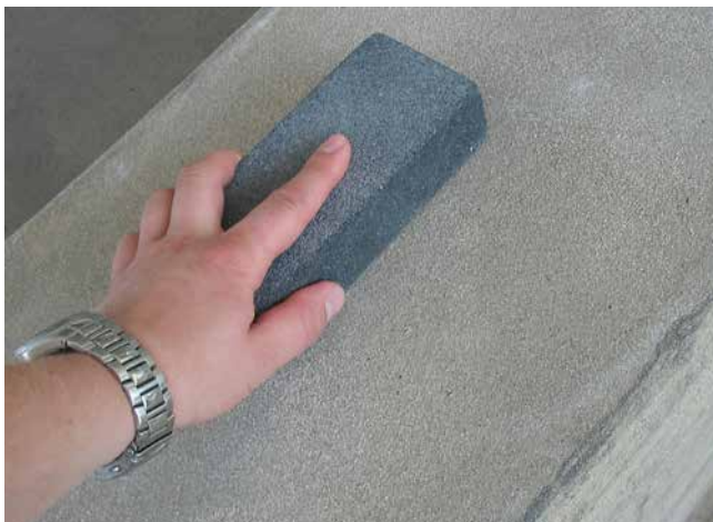
3 Überarbeiten der abgesandeten, trockenen Flächen mit Korundstein.
