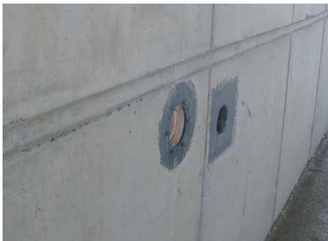
Verwahrnut rohauseitig hergestellt.
