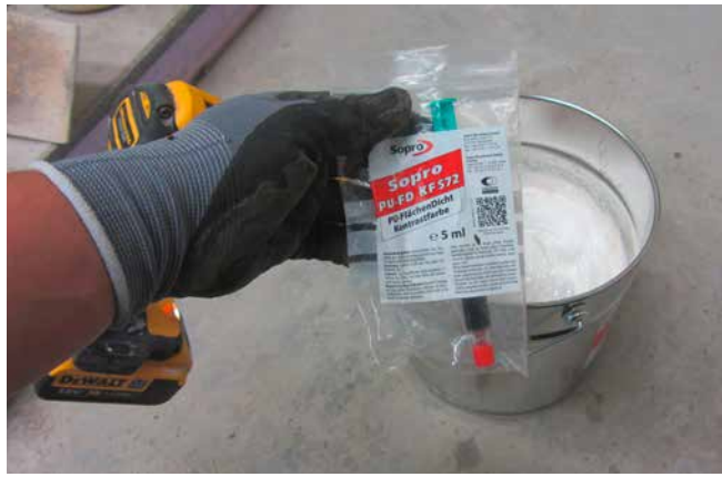
8 Sopro PU-FlächenDicht Kontrastfarbe kann dem Abdichtungsmaterial zugegeben werden, um eine bessere farbliche Unterscheidung zwischen Schicht 1 und Schicht 2 zu erhalten.
