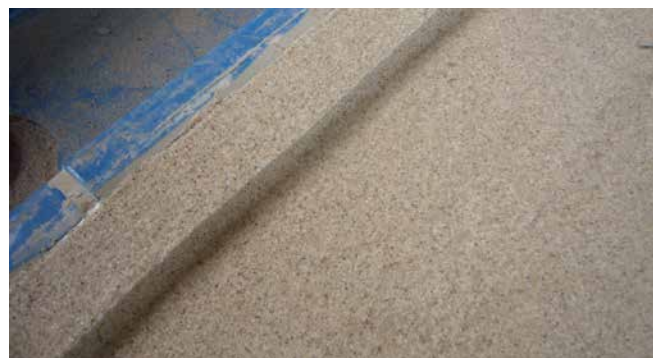
Aufbau einer kapillardichten Fuge hinter einem Beckenkopfstein vorbildlich gelöst.
