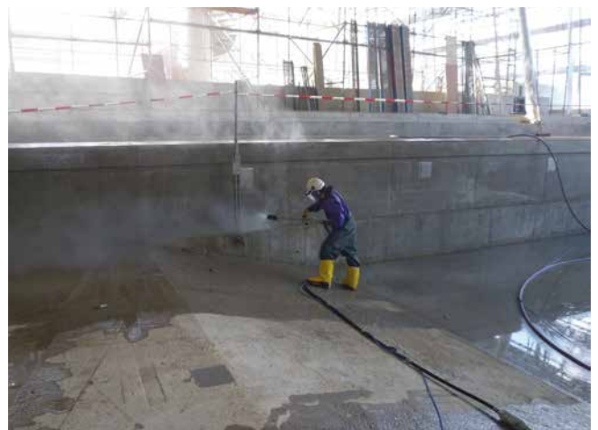
Strahlen der Betonoberfläche mit einem Sandstrahlgerät oder Wasserstrahlhochdruckgerät.
