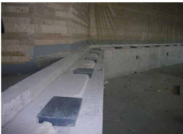
Entwässerungskästen zur Fixierung ausgerichtet.
