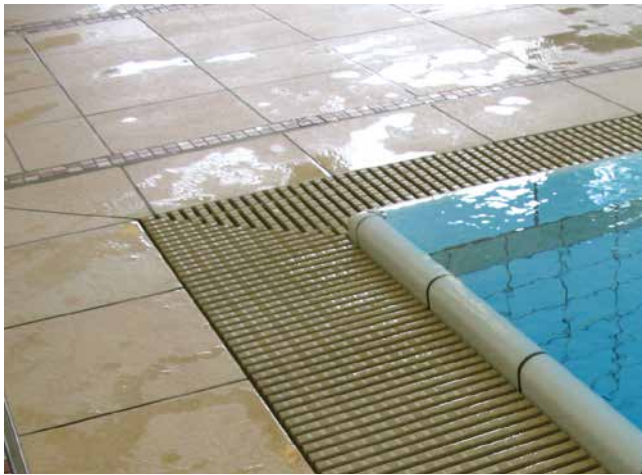
Sehr schön ist der hochliegende Wasserspiegel bei der Wiesbadener Rinne erkennbar, der etwa 3–4 cm höher steht als die Oberkante des Beckenumgangsbodens.
