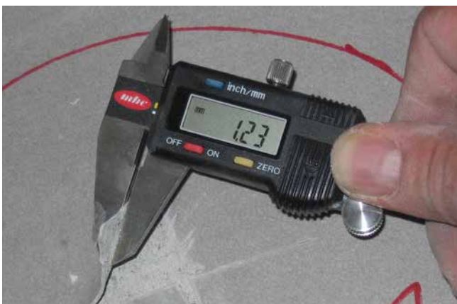
11 Prüfen der Gesamtschichtdicke der Verbundabdichtung.
