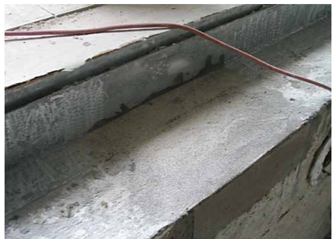
Vorbehandelter Entwässerungskasten mit Reaktionsharz und Gewebeeinlage.
