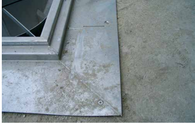
Edelstahlbecken mit breitem Flansch, auf welchem die Verbundabdichtung aufgetragen werden kann.
