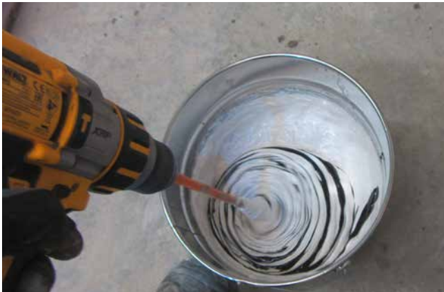
9 Die Sopro PU-FlächenDicht Kontrastfarbe wird in das Sopro PU-FlächenDicht eingemischt – eine graue Farbgebung entsteht.
