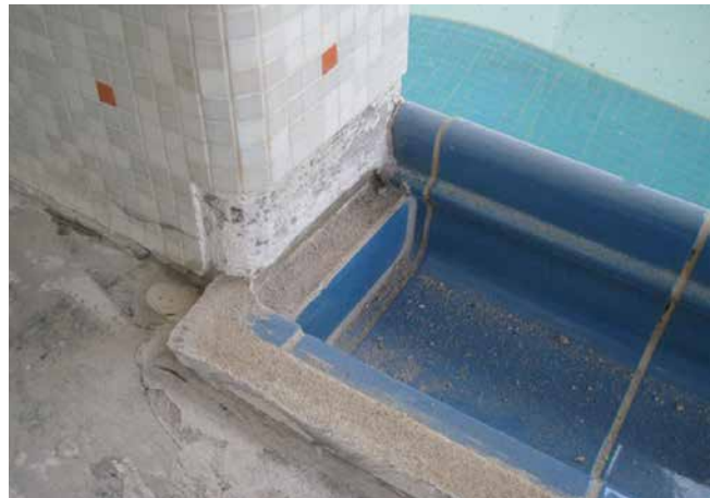
Kapillardichter Verguss am Ende einer Wiesbadener Rinne.
