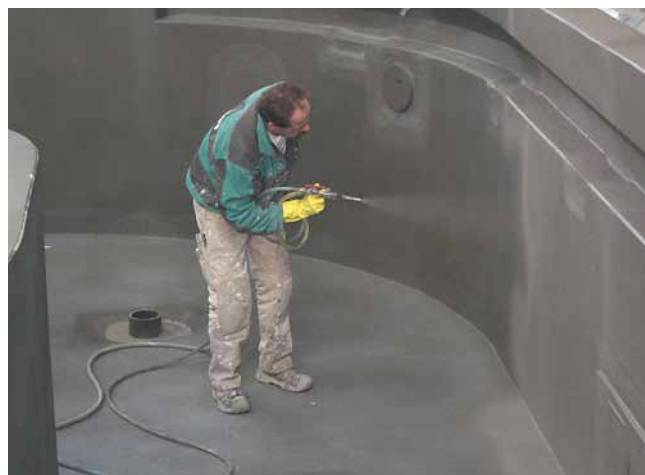
Applikation der Verbundabdichtung (Sopro TurboDichtSchlämme 2-K) mittels Spritzverfahren.
