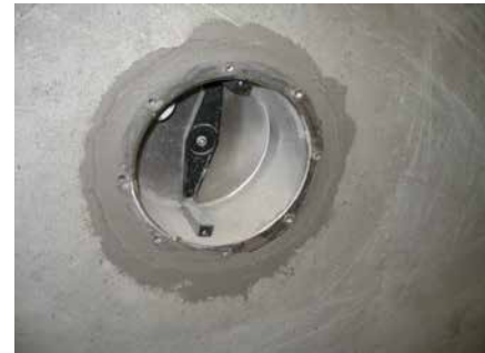
Verspachtelung des frei gestemmten Bereiches mit einem kapillardichten Reaktionsharzmörtel.
