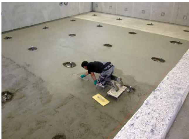
Ein schnell nutzbarer Verbundestrich (Haftbrücke Sopro Epoxi-Grundierung) lässt sich mit Sopro Rapidur® B5 herstellen.
