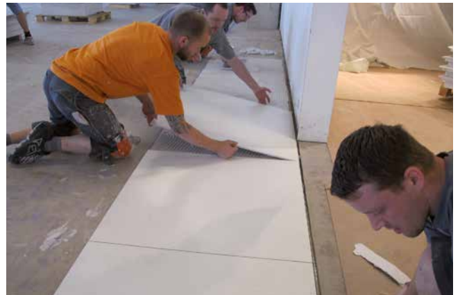
Wenige Stunden nach Einbau des zementären, schnell erhärtenden Fließestrichs Sopro Rapidur® FE ist die Großformatverlegung im Dünnbett ohne weiteres Ausgleichen möglich.
