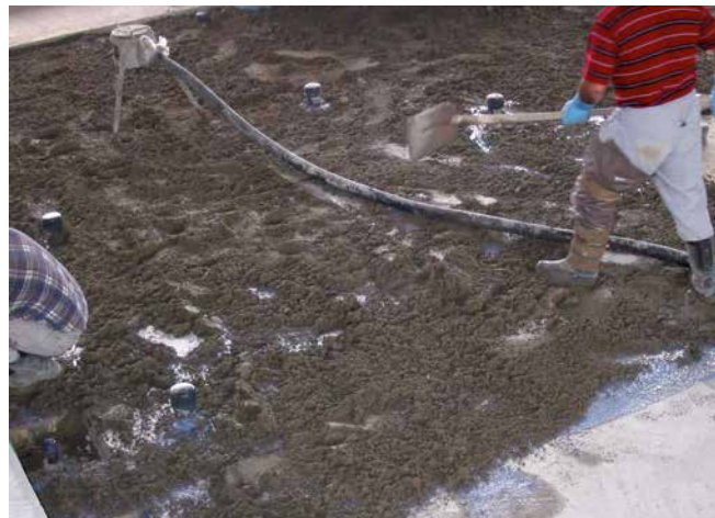
Zementestriche werden in erdfuchter Konsistenz verarbeitet.
