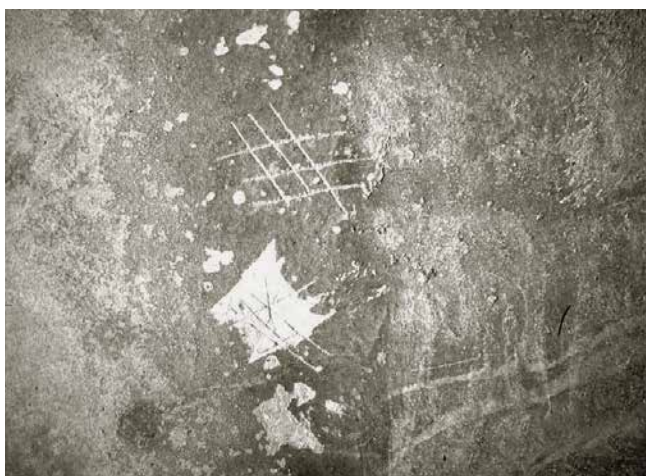
Überprüfung der Oberfläche auf Tragfähigkeit mittels Gitterritzprüfung.
