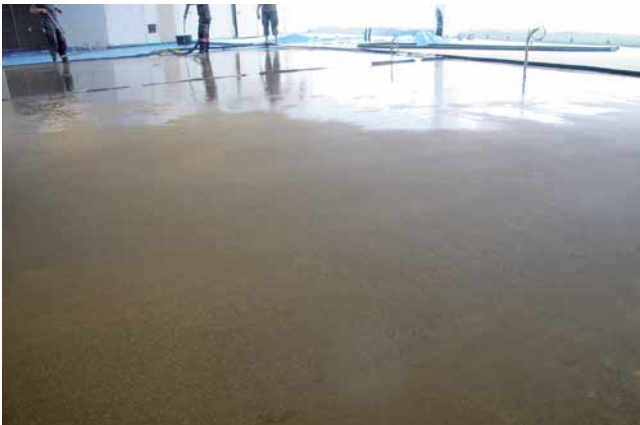
Mit Sopro Rapidur® FE lassen sich schnell abbindende und planebene Estriche herstellen, welche die Großformatverlegung von keramischen Platten vielfach erleichtert.
