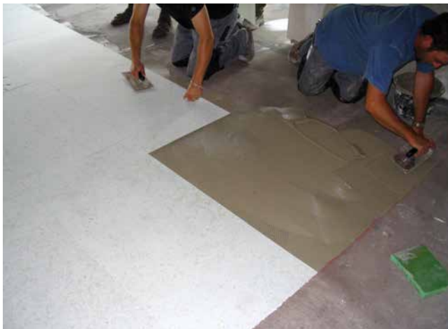
Verlegung einer Entkopplung mit Flexkleber auf einer Hohlbodenkonstruktion.
