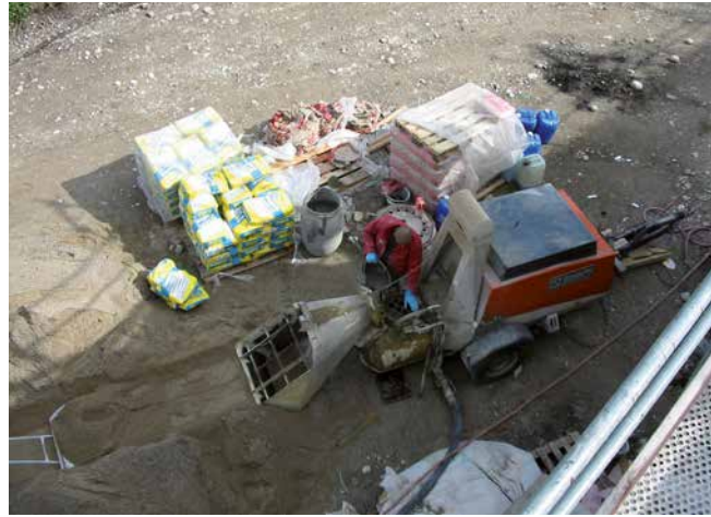
Herstellung eines Zementestrichs mit einer Estrichpumpe.
