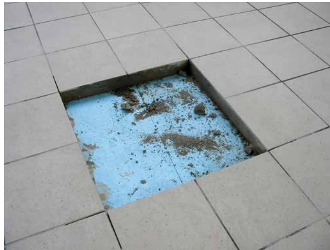
Der Estrich ist schwimmend auf einer Dämmung gelagert.
