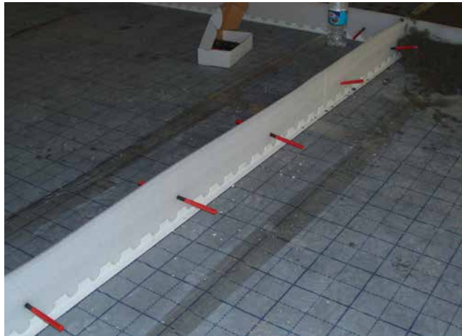
Sopro EstrichDehnDübel bereits im Bewegungsfugenbereich eingebaut.
