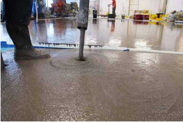
Einbau von Sopro Rapidur® FE – zementärer Fließestrich.
