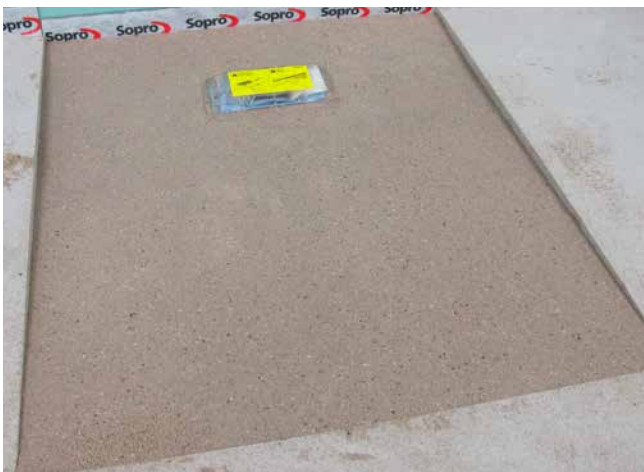
Duschfläche mit Reaktionsharzestrich.
