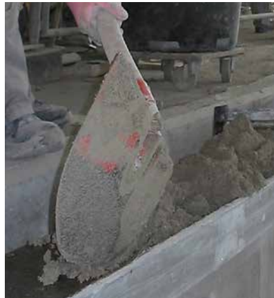
Einbringen des Estrichmörtels (Sopro Rapidur® M5) „frisch-in-frisch“ in die zuvor aufgetragene Sopro Epoxi-Grundierung.
