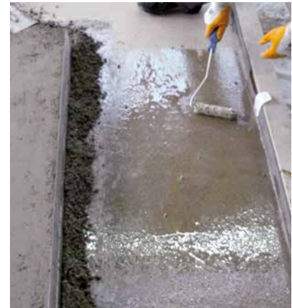
Epoxihaftbrücke für einen Verbundestrich.
