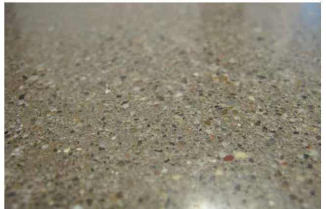
Durch das Schleifen und Polieren entsteht eine geschlossene, optisch ansprechende Terrazzo-Oberfläche.
