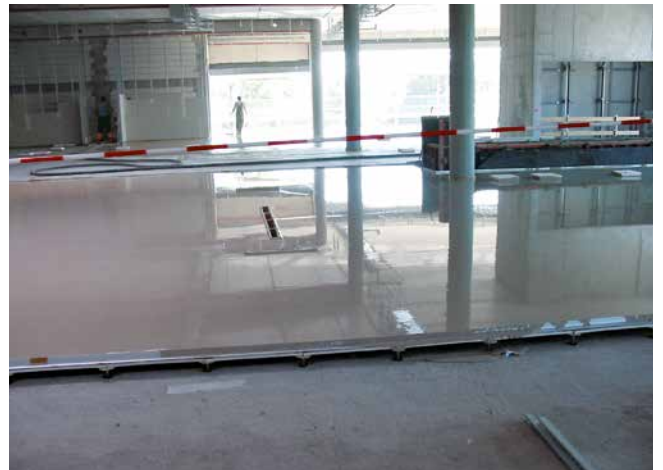
Calciumsulfatgebundener Fließestrich auf einer aufgeständerten Bodenkonstruktion eingebaut.
