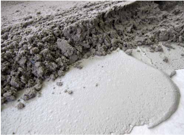
Einarbeiten des Estrichmörtels „frisch-in-frisch“ in die Haftschlämme.
