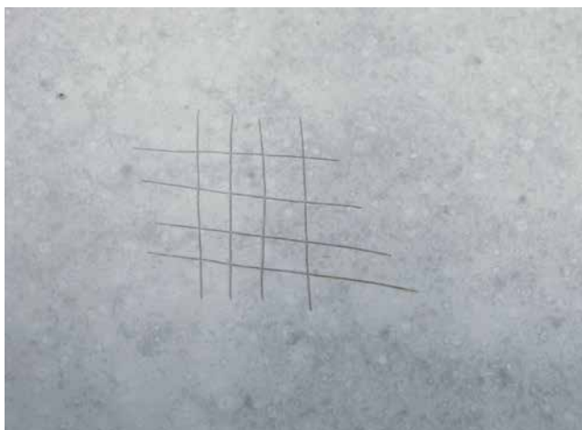
Nach dem Anschleifen sind nur noch scharfe Ritze erkennbar. Die Fläche ist optimal für eine Verlegung vorbereitet.
