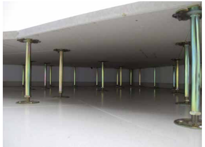
Hohlbodenkonstruktionen können mit den unterschiedlichsten Stützhöhen (je nach Haustechnikinstallation) aufgebaut werden.
